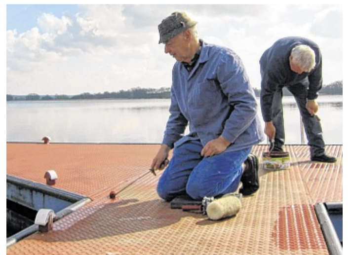
Das Streichen der Stege mit Rostschutzfarbe hatten Georg Funke (vorn) und Klaus Glaefcke übernommen. FOTO: URSULA PRÜTZ
